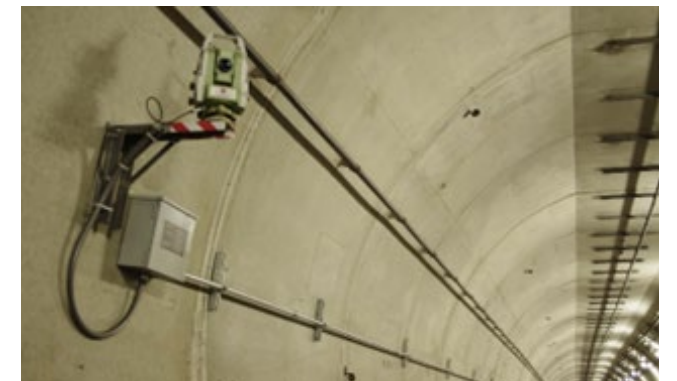
▲ Figura 2. Estación total robotizada en interior de túnel para medición de convergencias.
