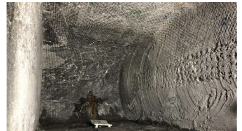
▲ Figura 8. Túnel excavado con una tuneladora MDM en el que se puede ver la malla metálica de alta resistencia en el techo del túnel.
