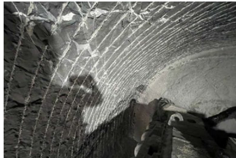
▲ Figura 5. Primer plano del corte del frente de roca en el túnel MDM.
