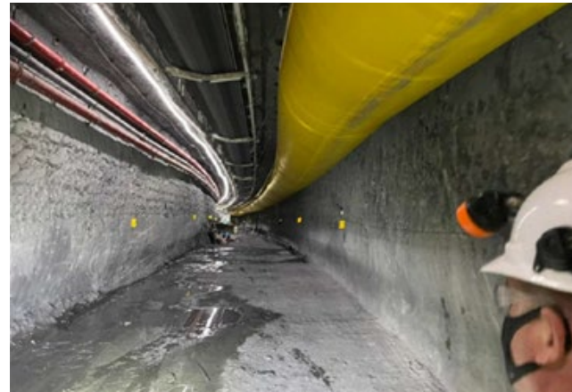
▲ Figura 10. Transportador de túnel montado en la clave.
