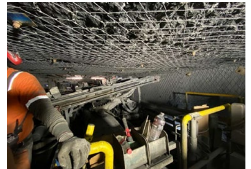
▲ Figura 9. Perforadoras hidráulicas de percusión para la fijación de pernos en el techo.
