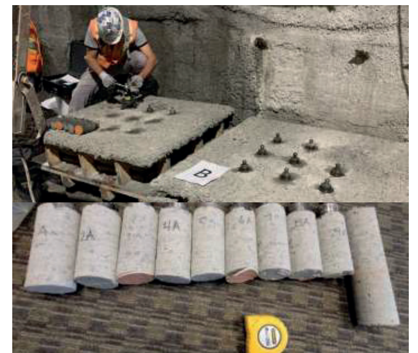
▲ Figura 1. Pruebas de arrancamiento in situ realizadas en el proyecto REM (doble arco, sección sur), Montreal, Canadá.
