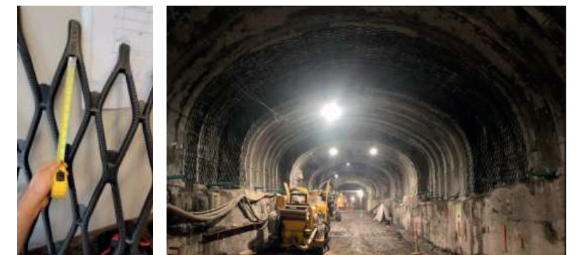
▲ Figura 3. Instalación de Dolenco Drain malla de drenaje entre las costillas de acero y en los muros cabeceros como parte del proyecto REM (doble arco, sección sur), Montreal, Canadá.
