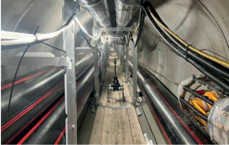
▲ Figura 7. Perro robot en el túnel mientras se tiraban las fundas.
