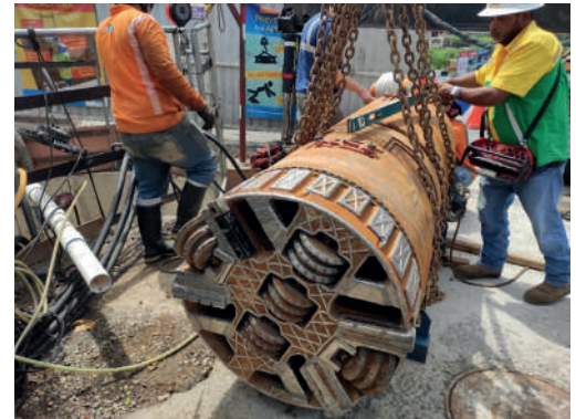
▲ Fotografía 14. Una de las micro tuneladoras en proyecto de saneamiento de San José.
