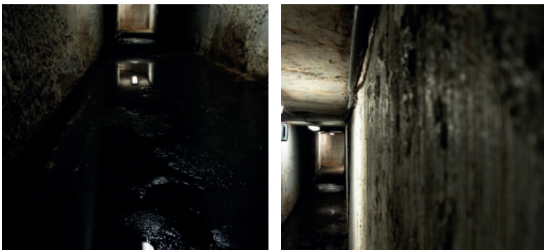
▲ Fotografía 6. Túnel bajo la Avenida Cuarta, San José (Curia Metropolitana, 2025).
