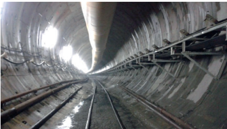
▲ Fotografía 11. Tramo de túnel del PH Torito ya revestido.
