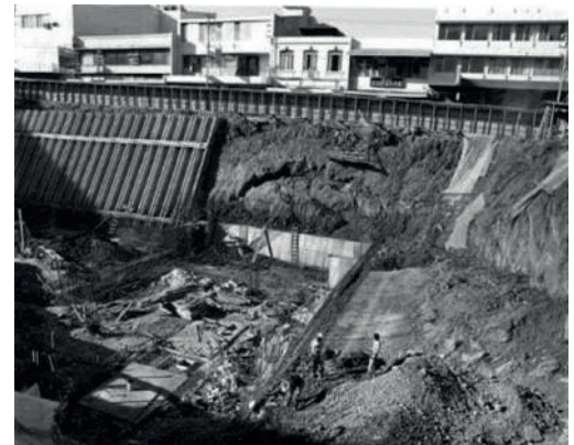
▲ Fotografía 15. Excavación de la Plaza de la Cultura.
