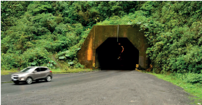
▲ Fotografía 17. Portal del túnel Zurquí (lado Caribe).
