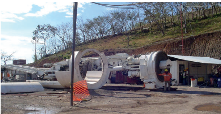
▲ Fotografía 10. Ensamblaje de máquina tuneladora abierta, fuera del túnel del PH La Joya.
