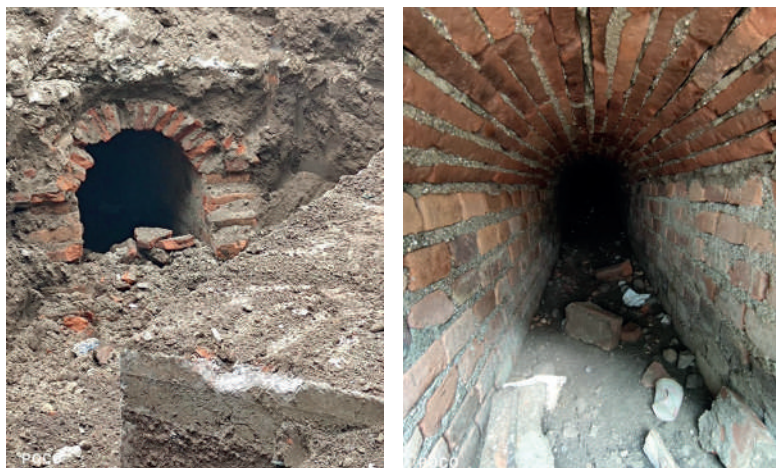
▲ Fotografía 1. Alcantarillas antiguas bajo la Plaza Mayor, Cartago.
