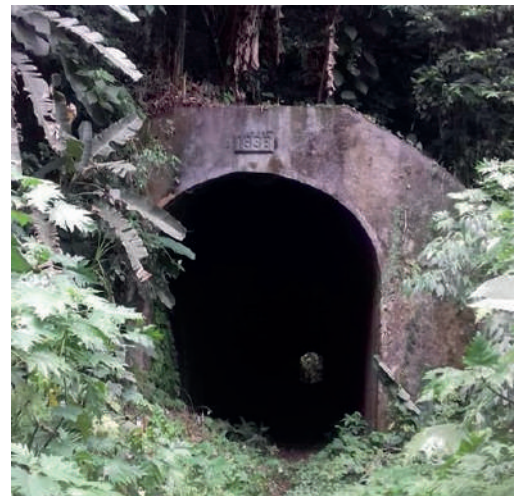
▲ Fotografía 7. Túnel “Camp”, ferrocarril al Atlántico.
