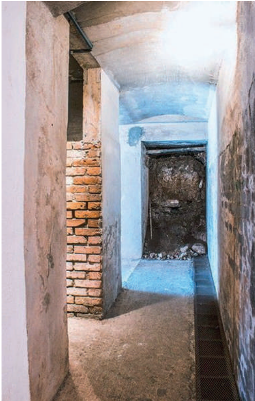
▲ Fotografía 2. Túneles del Cuartel Bellavista (restaurados).
