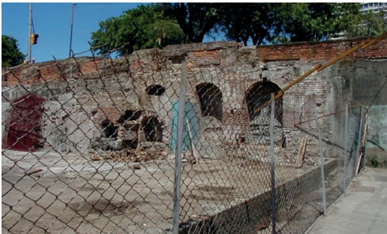
▲ Fotografía 5. Túneles sanitarios de calicanto, expuestos durante una excavación en San José.
