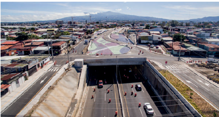
▲ Fotografía 18. Túnel de Circunvalación Norte (RN 39).
