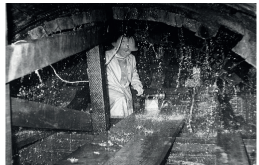
▲ Fotografía 8. Túnel de Tapantí. Condiciones de trabajo y tipo de soporte.
